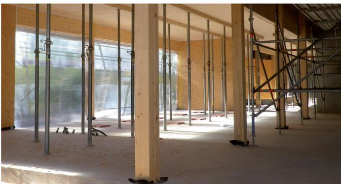
**Holz-Beton Hybridbauweise im Rohbau**
